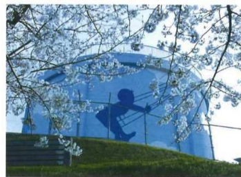
小林配水池（宝塚市千種1丁目地内）
