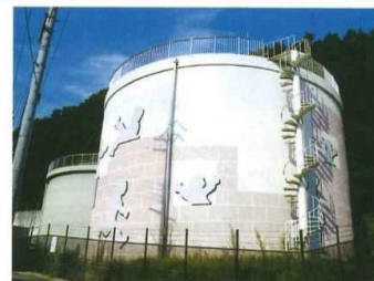
中筋下配水池（宝塚市山本台3丁目地内）
