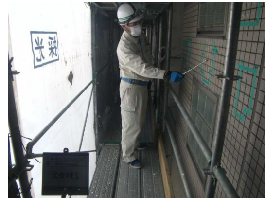
建築物の外壁検査
