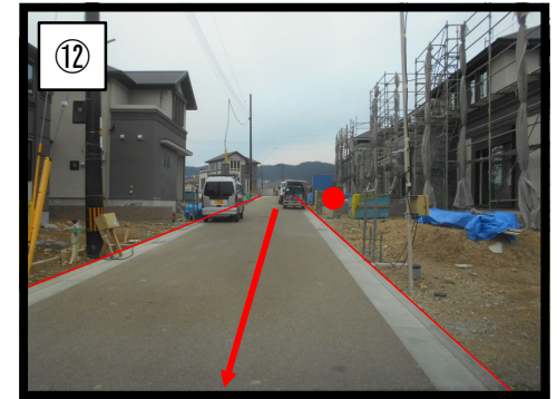
市道4543号線起点側
