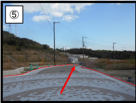
市道4539号線起点側
