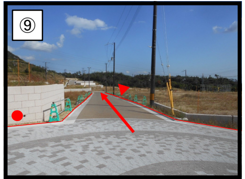
市道4541号線起点側
