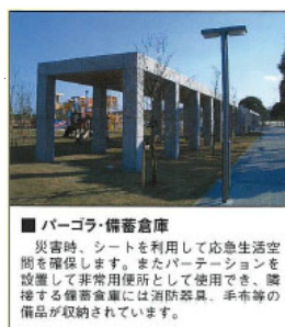
末広中央公園の防災設備
