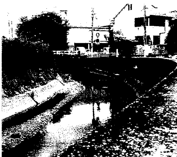
〈米谷.国道水路合流部・黒鉾橋付近〉
