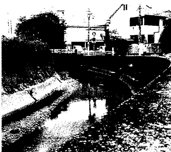
〈米谷.国道水路合流部・黒鉾橋付近〉
