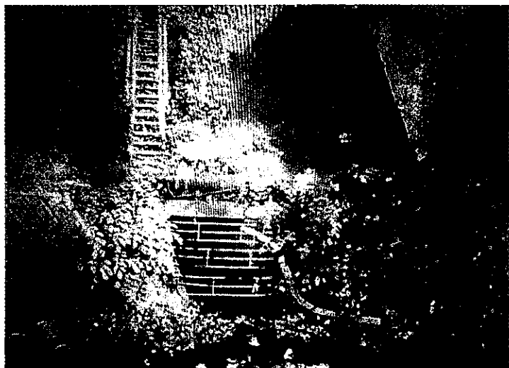
施工前の吐口付近(1.11.21)
