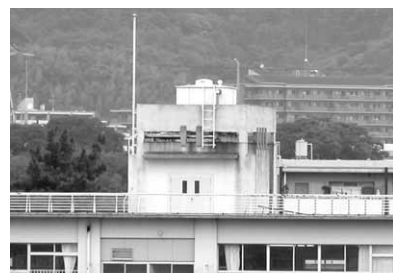
学校の高架水槽
