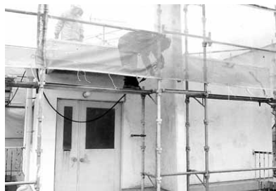
市内業者による公共工事
