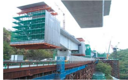
坊川第三橋の工事現場
