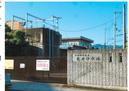
廃止予定の小林・亀井浄水場
