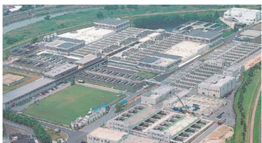
阪神水道企業団の猪名川浄水場
