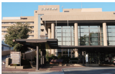
市立病院の外観
