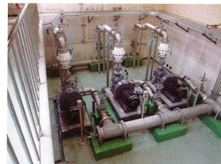
山手台下加圧所ポンプ更新工事
