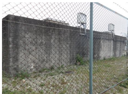
白瀬上配水池
