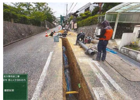
管路更新工事
