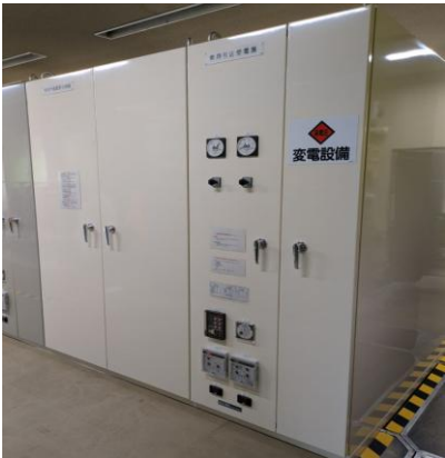
惣川浄水場受変電設備改良工事
