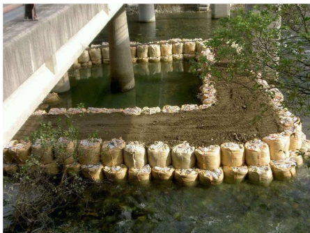
河川内橋脚耐震補強の工事例（河川内において、オープン掘削（緩い勾配）で床掘りし、ポンプ排水で対応している例）
