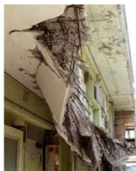
マンションの2階廊下部分が崩落した事例
