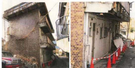
外壁・手すりが崩落した事例
