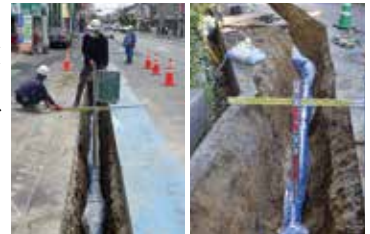
水道管路の工事
