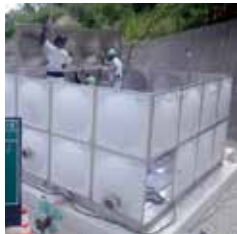
配水池の工事
