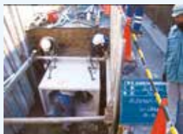
管きよの老朽化対策工事
