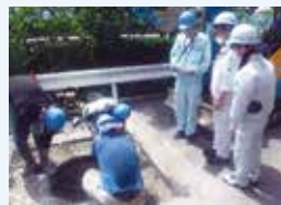
マンホールの補修・交換
