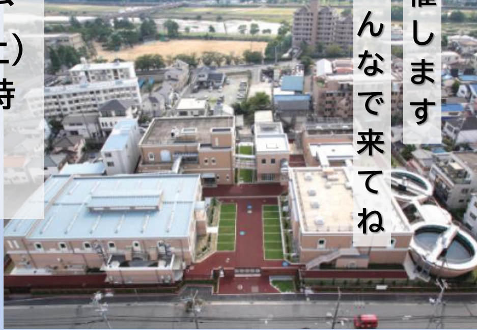
小浜浄水場の全景
