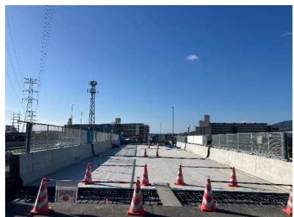
架設完了状況
