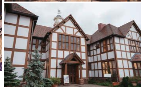
イギリスから輸入した材料と工法で建てられた 本格イギリス式の建物
