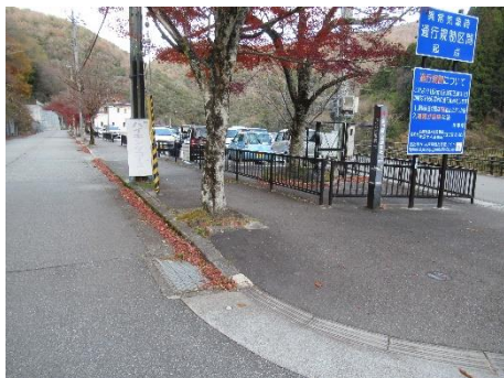
視覚障害者誘導用ブロックが整備されていない
