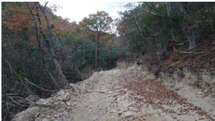
【作業道の状況】
