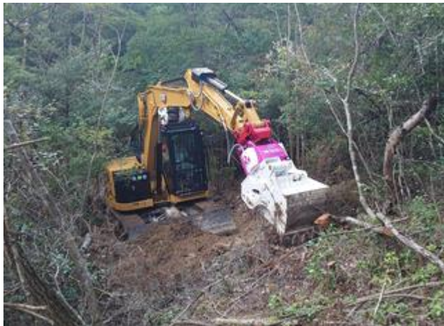
【作業道の開設風景】
