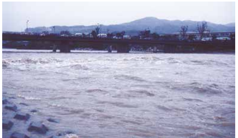
武庫川の増水（宝塚新大橋付近）
