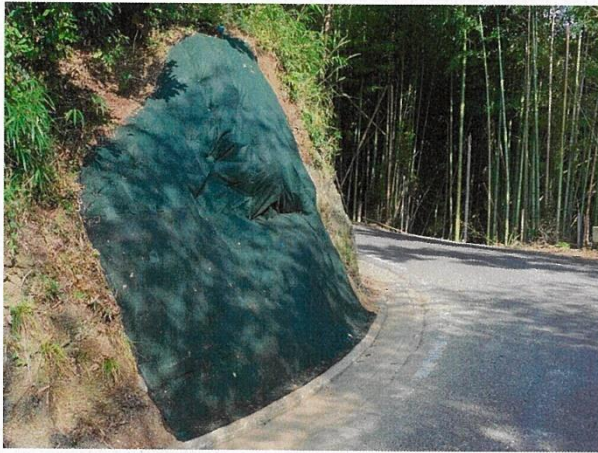
構造物周りの埋戻土の保護事例
