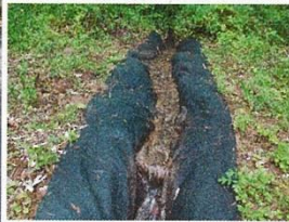
水路工への適用事例
