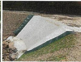
構造物周りの埋戻土の保護事例
