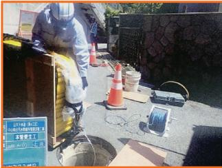
新しい管の材料をマンホールから挿入します
