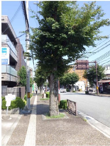
歩道部分(現状)
