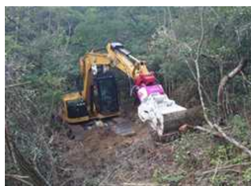
作業道の開設
