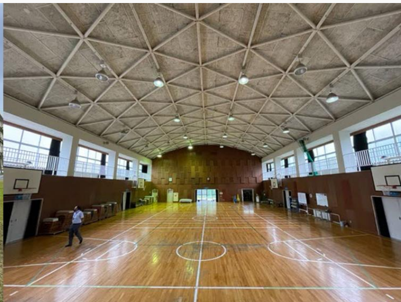
小学校 屋内運動場
