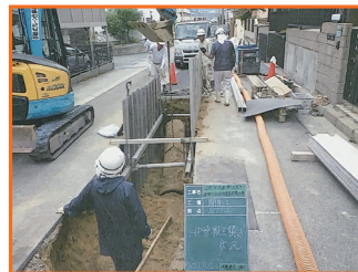
古い污水管を掘り出します
