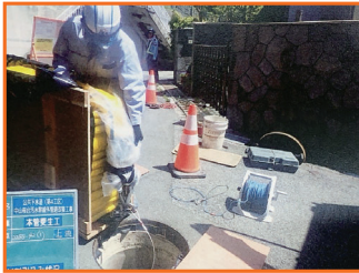
新しい管の材料をマンホールから挿入します
