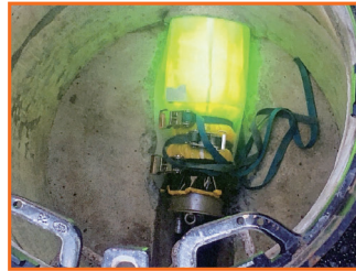
古い管の内面に貼りつけ、光や熱で固めます
