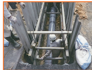
地震に強い污水管に入れ替えます
