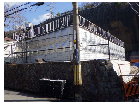
高台下配水池更新工事
