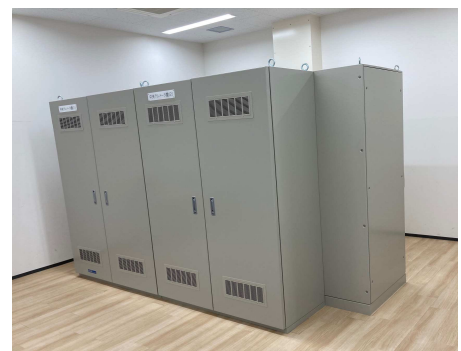
阪水系中央監視設備更新工事
