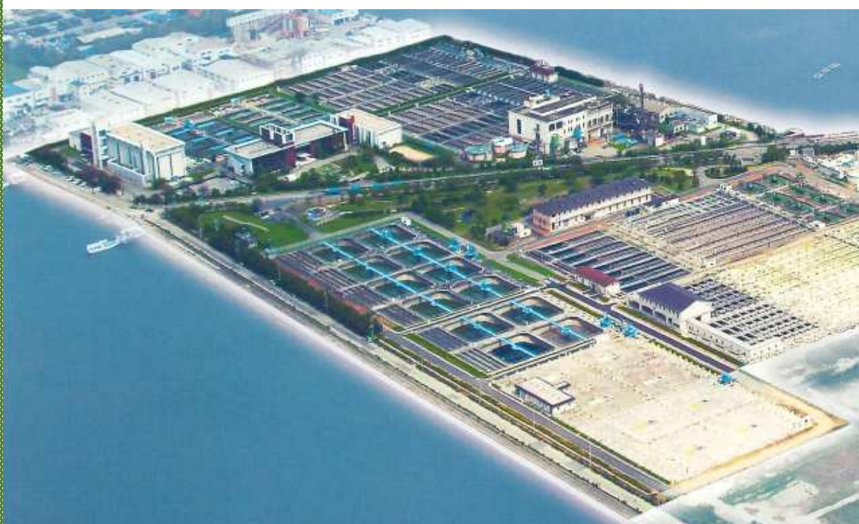
武庫川下流浄化センター（尼崎市）
