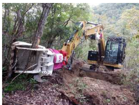
【フェラバンチャーによる伐採】
