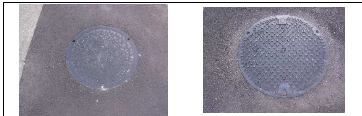
図 3-2-1 マンホール蓋（左：デザイン型、右：ノンスリップ型）
