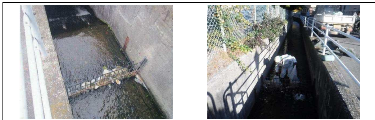
図 3-1-7 水路のスクリーン巡視・清掃作業の状況
