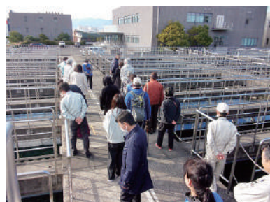
↑武庫川下流浄化センター 見学会の様子
