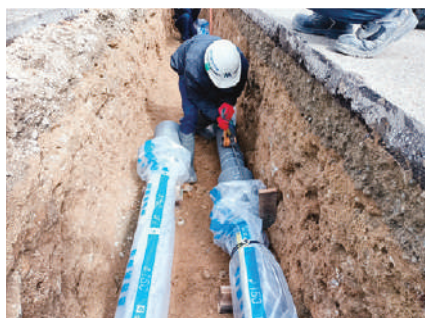
耐震化工事の様子
