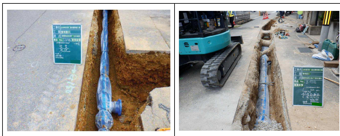
図 管路更新工事の様子
