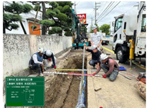
図 管路更新時に合わせた耐震化工事
