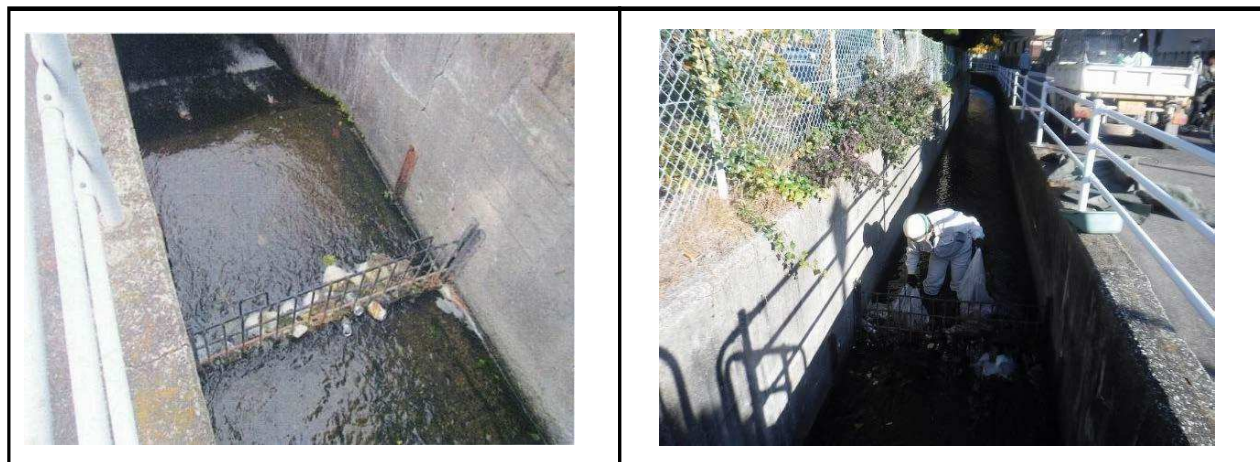
水路のスクリーン巡視・清掃作業の状況
