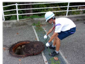
マンホールを開ける
