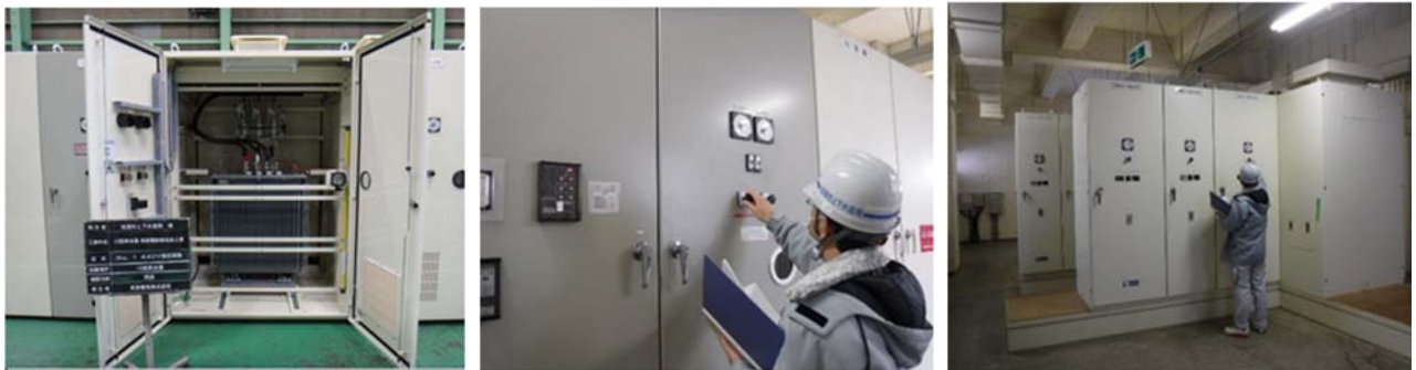
図 3-I-17 変圧器の更新作業と電気設備点検の様子
