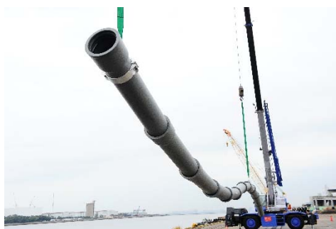
図3-I-2 管路更新時に合わせた耐震化耐震継手管の布設工事と変位実験 （参照：一般社団法人日本ダクトイル鉄管協会）
