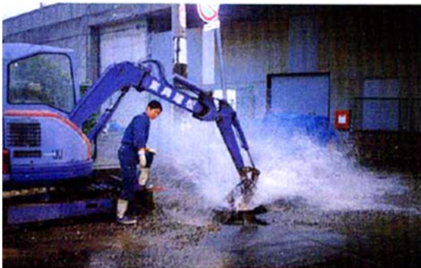
図 3-I-14 阪神・淡路大震災での被災状況 (左：配水管の破損、右：川下川貯水池導水トンネル異常湧水)
