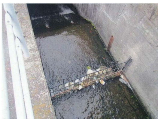
図 3-I-7 水路のスクリーン巡視・清掃作業の状況
