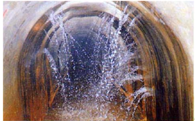
図 3-I-14 阪神・淡路大震災での被災状況 (左：配水管の破損、右：川下川貯水池導水トンネル異常湧水)
