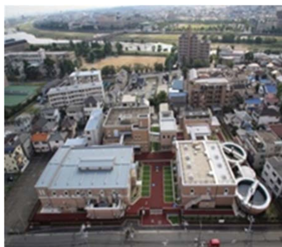
図 3-II-3 地下水を水源とする小浜浄水場
