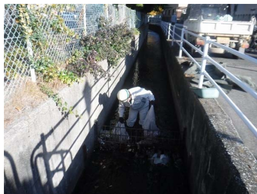
図 3-I-7 水路のスクリーン巡視・清掃作業の状況
