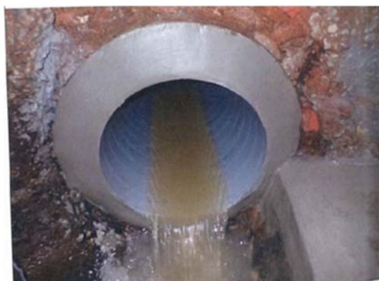
図 3-Ⅱ-9 管渠改築状況（巻き出しリングによる製管）
