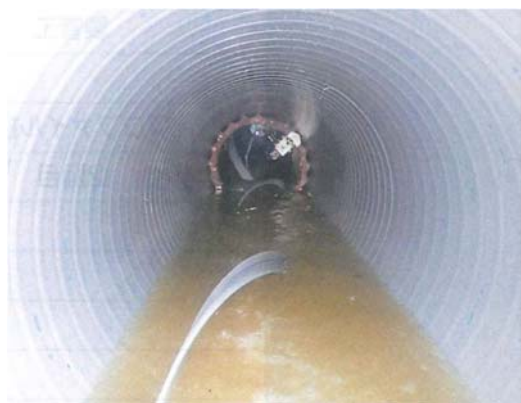
図 3-Ⅱ-9 管渠改築状況（巻き出しリングによる製管）
