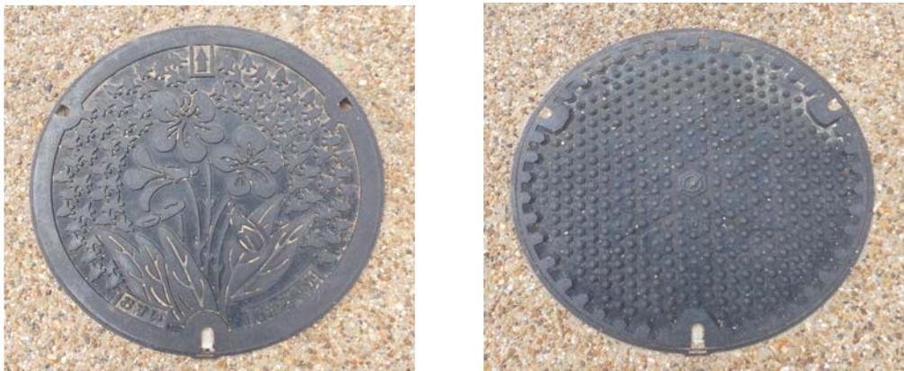
図 3-II-1 マンホール蓋（左：デザイン型、右：ノンスリップ型）
