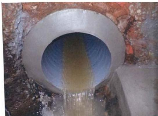
図 3-II-9 管渠改築状況（巻き出しリングによる製管）
