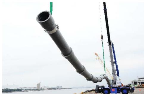
図 3-I-2 管路更新時に合わせた耐震化耐震継手管の布設工事と変位実験
