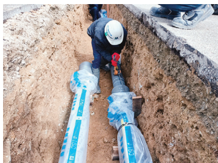
耐震化工事の様子
