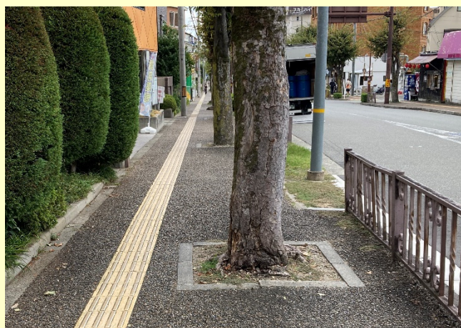
【歩道の有効幅員不足】
