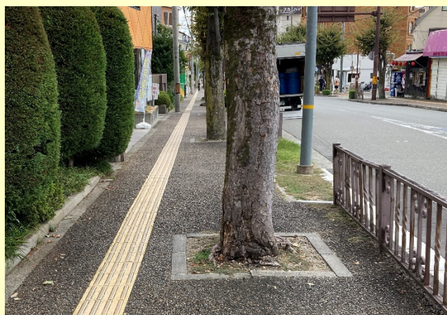
【歩道の有効幅員不足】
