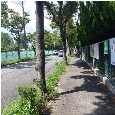
歩道部分(現状)
