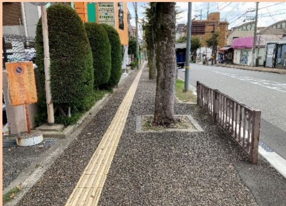
大木化+根系の肥大（植樹樹規格の限界） 歩道有効幅員不足 ⑤逆瀬川米谷線 ケヤキ
