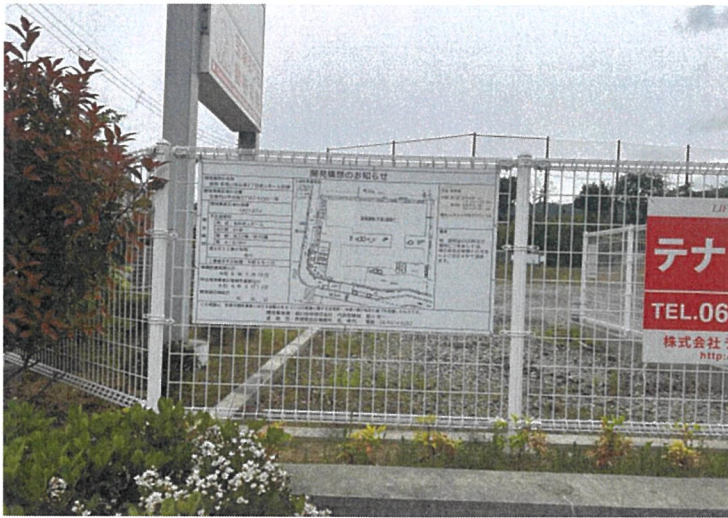
東側看板設置(近景)
