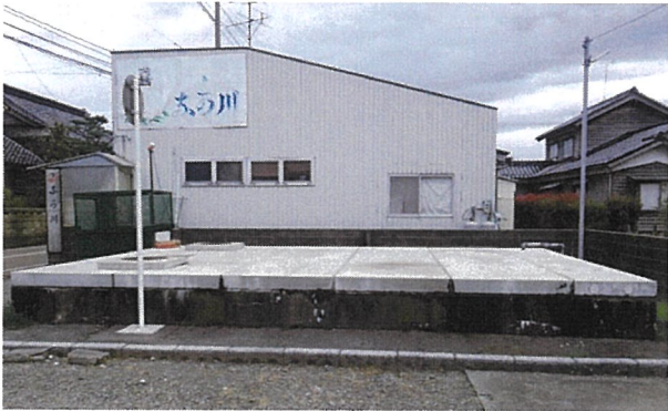
【現場打ち水槽の蓋】
