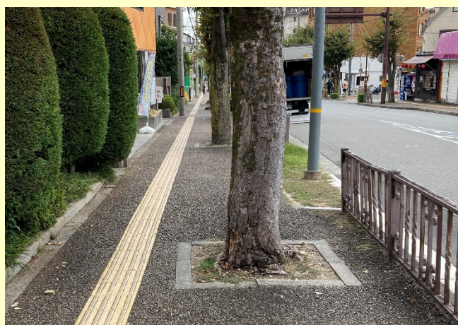
【歩道の有効幅員不足】
