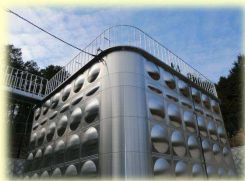
地震に強い配水池へ
