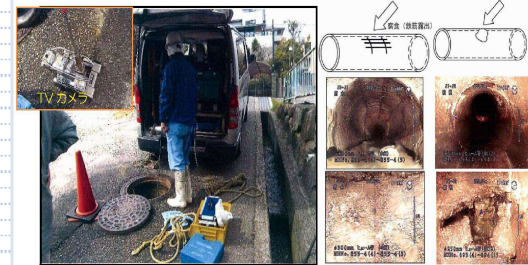
テレビカメラを入れて 下水道施設を視覚的に調査
