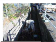
水路の 巡視と清掃
