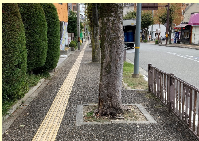
【歩道の有効幅員不足】
