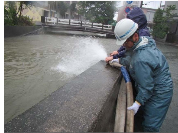
浸水時の水防作業状況
