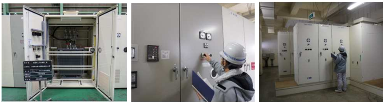
図 3-I-17 変圧器の更新作業と電気設備点検の様子
