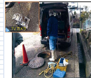
テレビカメラを入れて 下水道施設を視覚的に調査
