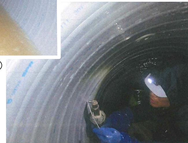
管渠改築状況②
