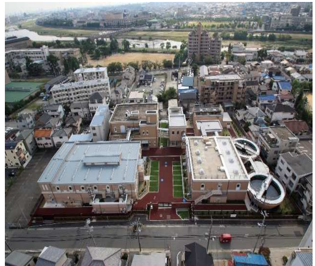
図 3-II-3 地下水を水源とする小浜浄水場
