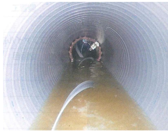
管渠改築状況①
