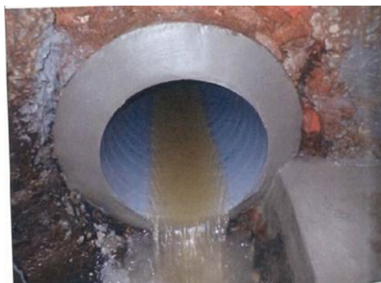
図 3-II-9 管渠の改築状況(巻き出しリングによる製管)
