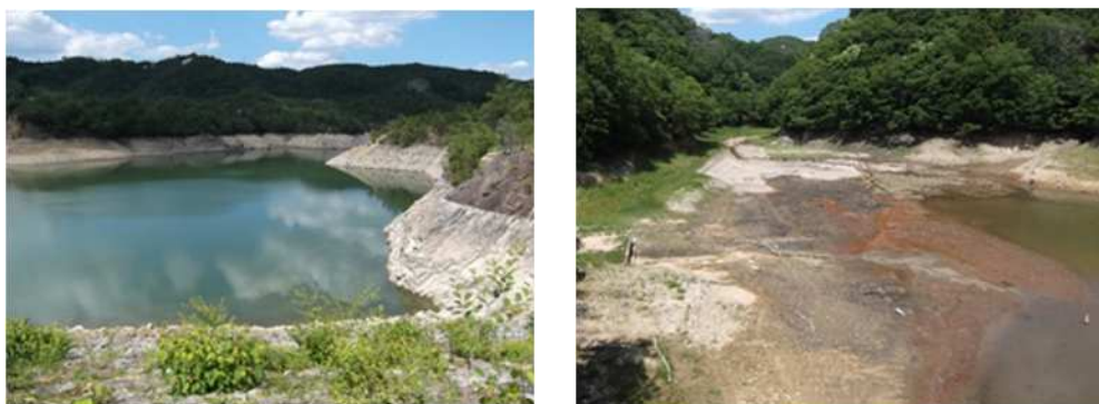
図 3-II-6 水位低下した川下川貯水池と少雨傾向時の貯水池上流部
