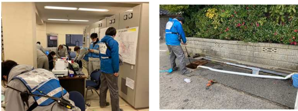
図 3-I-16 令和6年能登半島での応急復旧業務の様子
