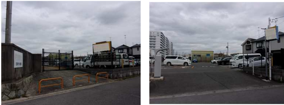
図 3-III-4 跡地利活用例（高松浄水場）
