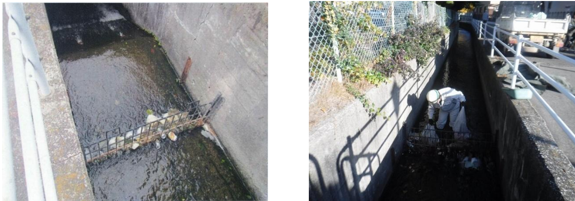
図 3-I-7 水路のスクリーン巡視・清掃作業の状況
