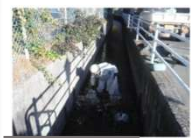
水路の 巡視と清掃
