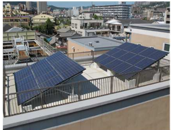
図 3-II-7 小浜浄水場の太陽光パネル
