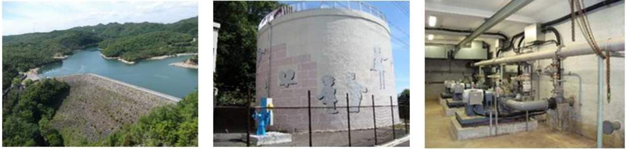
図 3-II-2 宝塚市の水道施設（左：川下川貯水池、中：配水池、右：ポンプ場）
