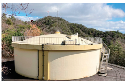
配水池加圧所耐震化(更新)事業 4,000万円
