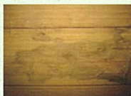
屋上の防水層劣化 による雨漏れ被害
