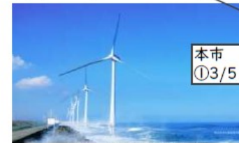
【洋上風力発電設備】
